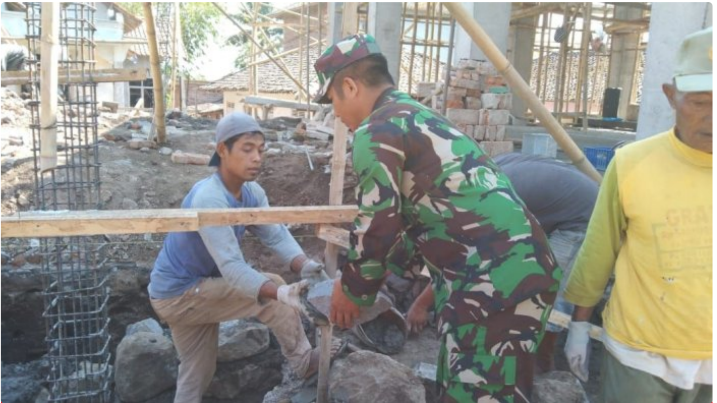
Serda Nasikin bantu pemasangan batu pondasi masjid
